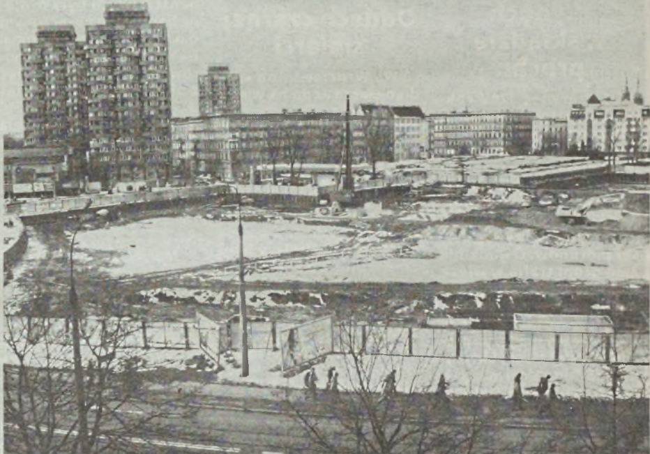
Tak dziś wygląda teren, gdzie stanie galeria Echo.
