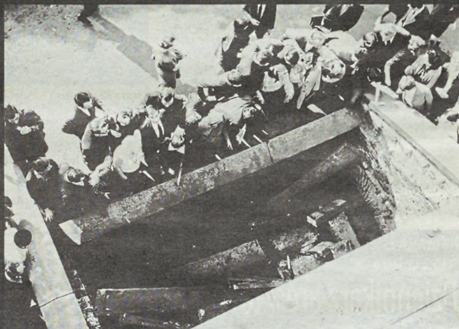
Balustrada runęła na żaków z prawej strony galerii wzgórze. Zdjęcie zrobiono kilka godzin po wypadku.
