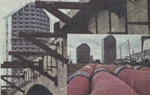
Na moście zostanie wymieniona cała instalacja rurowa i okablowanie.
