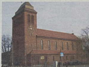
Wyremontowane elewacja i dach kościoła
