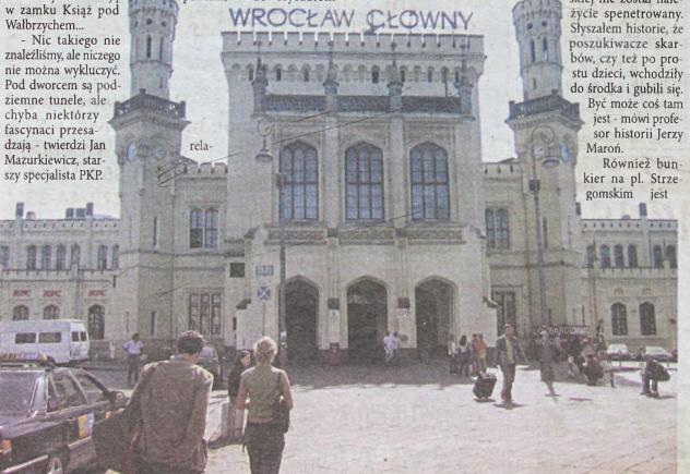
Pod wrocławskim dworcem znajdują się zalane wodą kazamaty
