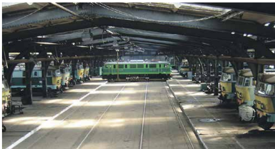
Hala napraw lokomotyw
