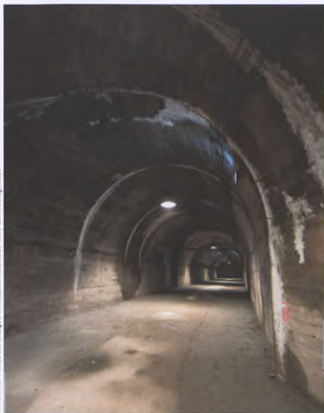
Wydrążone pod zamkiem tunele w części zostały wybetonowane, w części zaś wykute są w surowej skale
