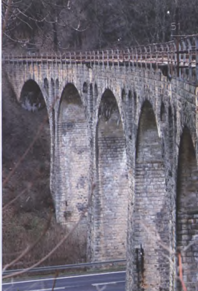
Lewin Kłodzki, wiadukt kolejowy
