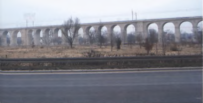
Bolesławiec, wiadukt kolejowy
