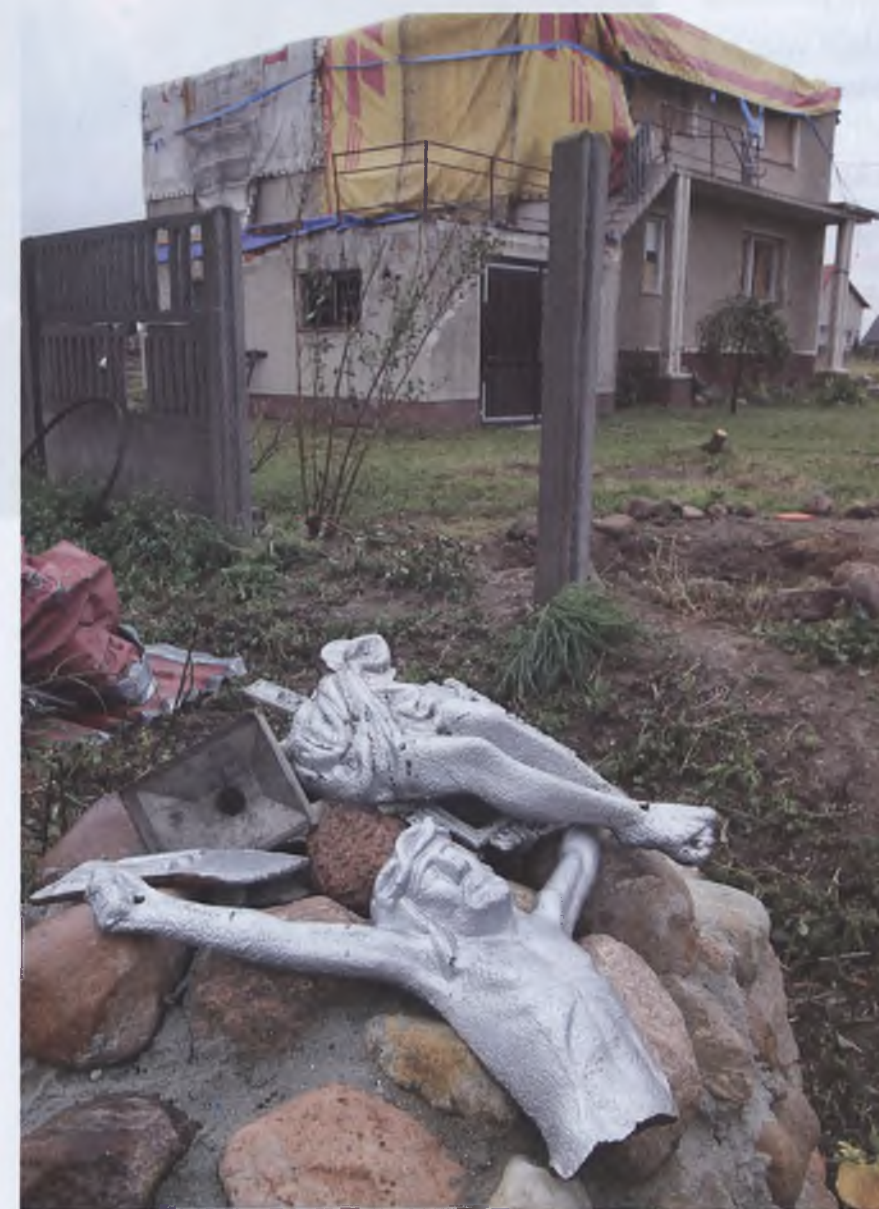
Zniszczenia po przejściu trąby powietrznej we wsi Adamów
