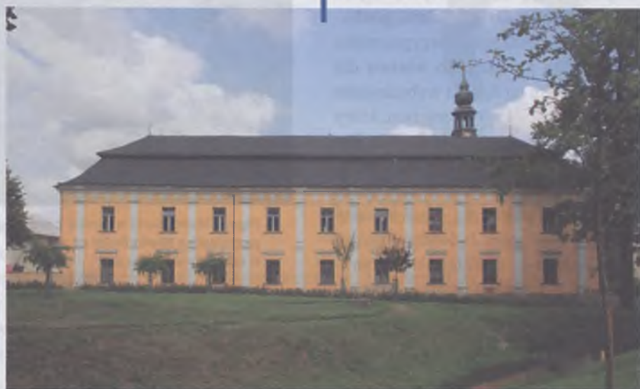
Dawne kolegium oo. pijarów w miejscowości Bílá Voda (Czechy)
