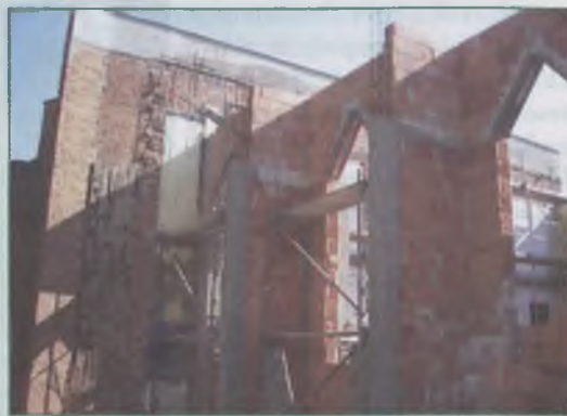
W trakcie przebudowy
