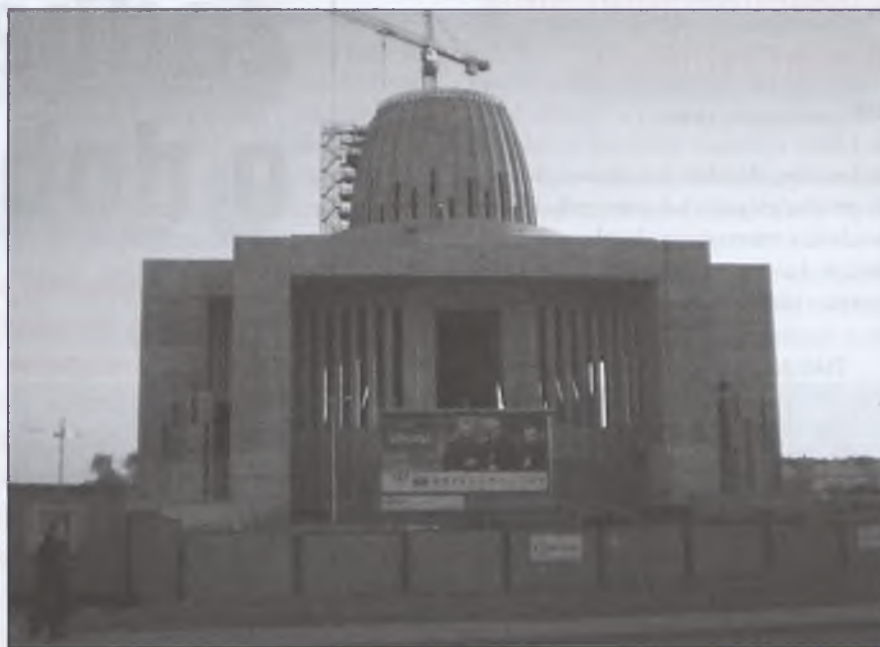
Trwa budowa Świątyni Opatrzności Bożej
