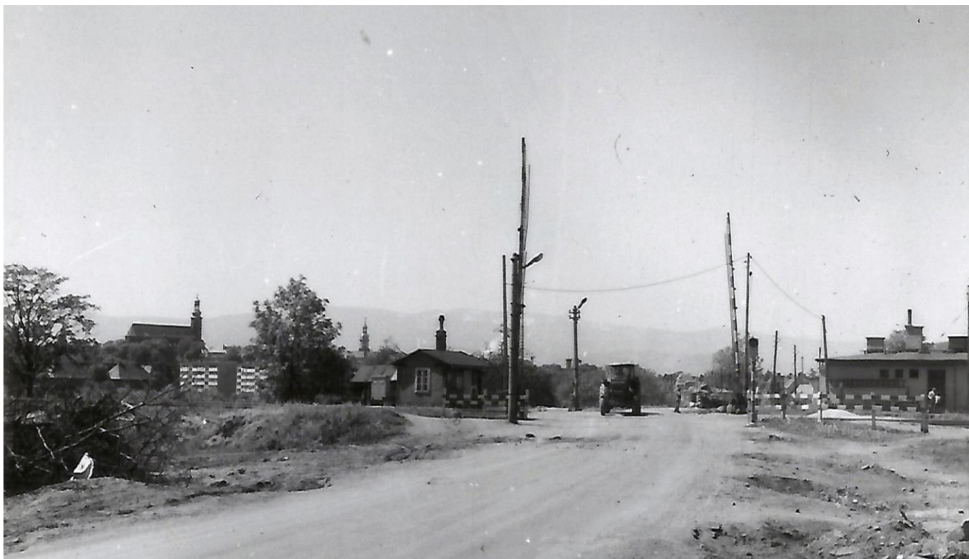
Przejazd kolejowy widziany od strony Zabobrza. Rozpoczęły się wycinki drzew.
