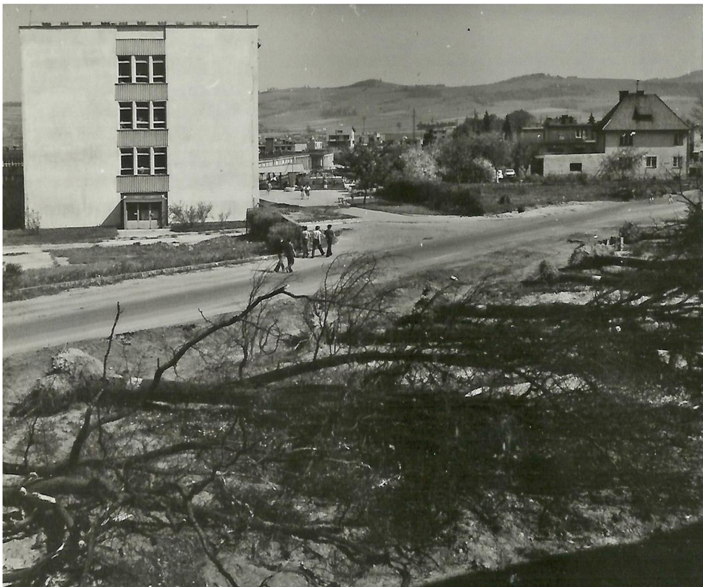
Powalone drzewa tuż przed budynkiem Technikum Budowlanego.
