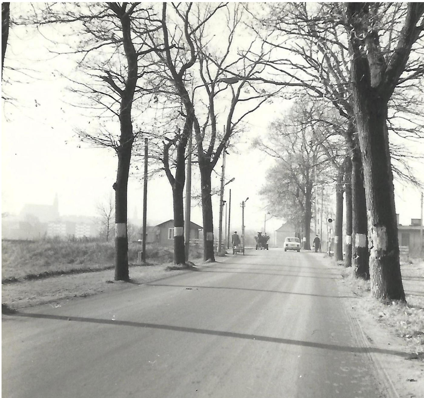
Legnicka przed przejazdem kolejowym od strony Zabobrza.
