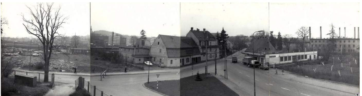
Skrzyżowanie ulic Grunwaldzkiej i Legnickiej. Z widocznych na tym zdjęciu budynków nic nie zostało.
