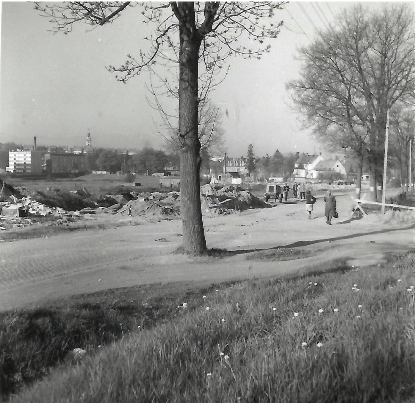
Legnicka tuż za torami kolejowymi. Widok w stronę Grunwaldzkiej. Z budynku Legnicka 6 pozostał już pusty plac.
