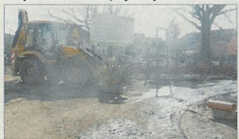
Foto: Budowa sieci kanalizacyjnej, miejscowość Kunów, gmina Zgorzelec
