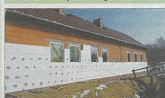
Foto: Roboty Budowlane, Budynek Techniczny - teren oczyszczalni ścieków w Sulikowie
