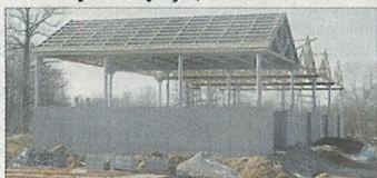
Foto: Roboty Budowlane, Magazyn Osadu Odwodnionego - teren oczyszczalni ścieków w Sulikowie
