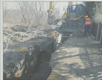
Foto: Budowa sieci kanalizacyjnej, ul. Św. Teresy, Sulików, gmina Sulików
