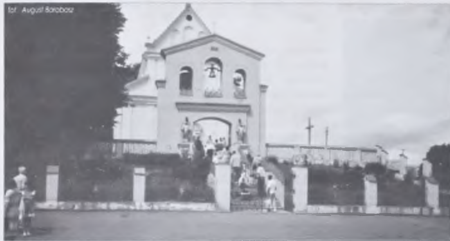
Kościół w Siemianowce niedaleko Lwowa już całkowicie wyremontowany
