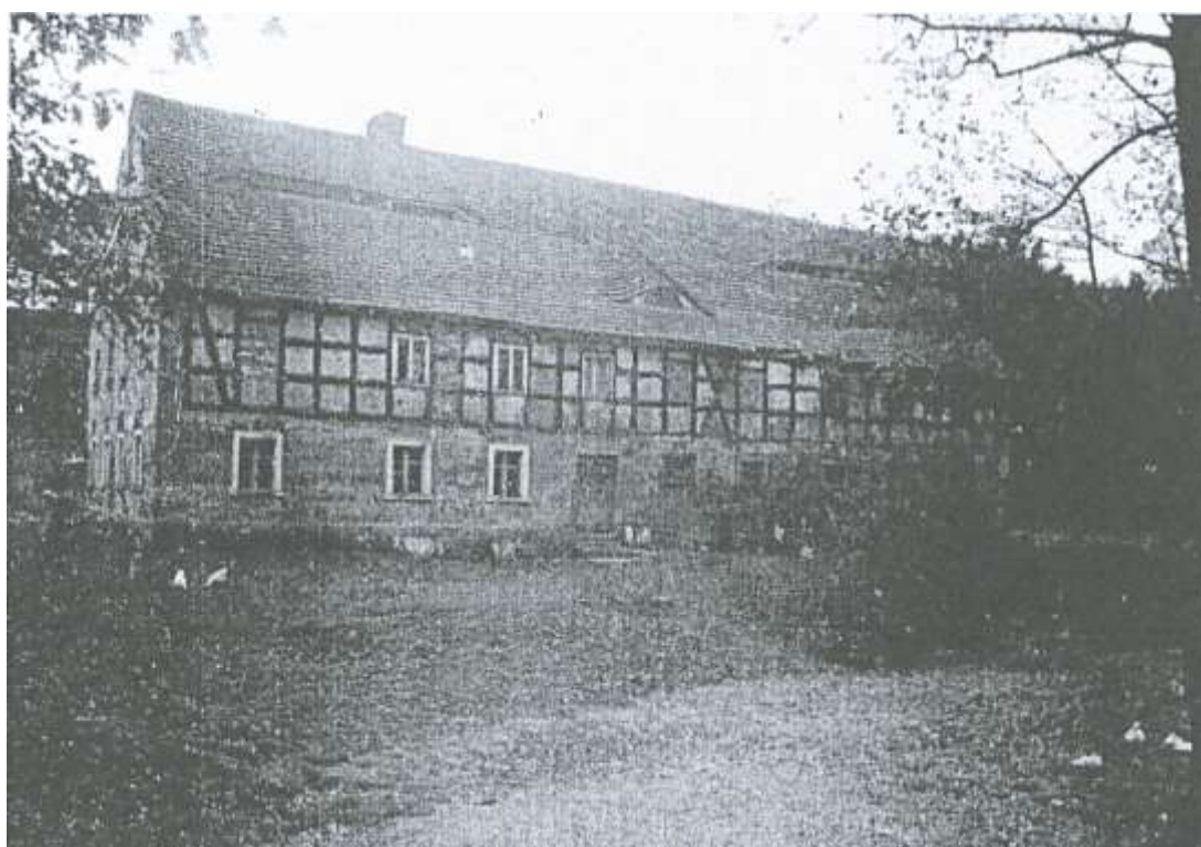
Dom mieszkalno-gospodarczy nr 1 w Kondratowie.
