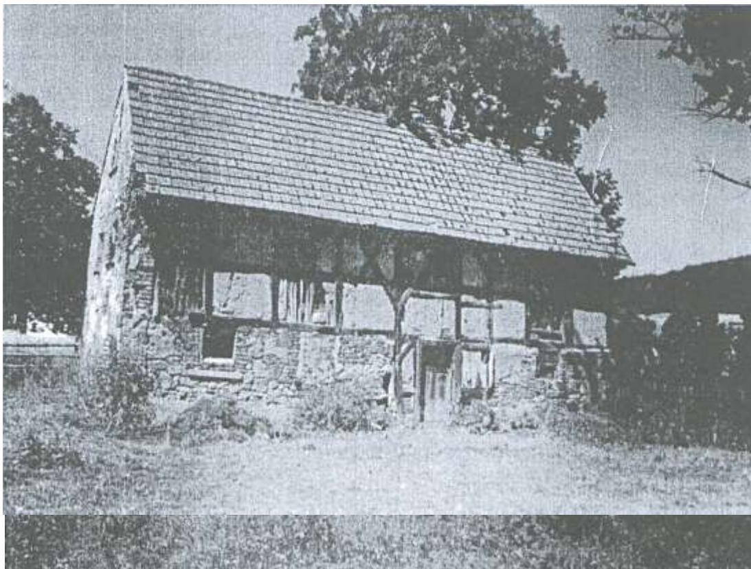
Budynek mieszkalno-gospodarczy obok zagrody nr 52. Opuszczony. Przykład budownictwa z XIX wieku, o mieszanej konstrukcji ścian i charakterystycznym układzie drewnianego
