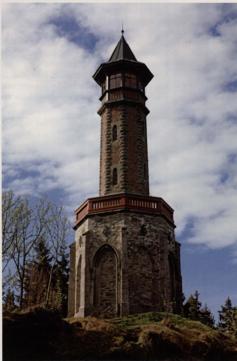
Widok wieży od strony północnej
