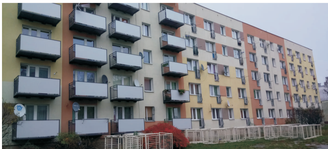
1. Zdjęcie autora zrobione w trakcie realizacji. (technologia balkonów „samonośnych”) Na zdjęciu widoczna jest część, na której portfenetry zostały już rozbudowane i lokale posiadają balkon. W głębi widoczna jest część budynku oczekująca na realizację.
