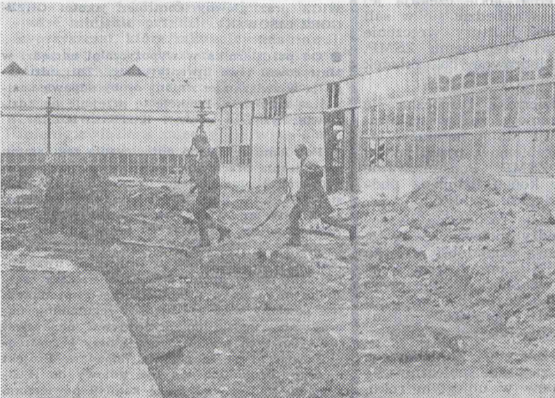
W dokumentach Wojewódzkiej Konferencji Sprawozdawczo-Wyborczej PZPR w Legnicy mówi się o zakończeniu inwestycji modernizacyjnych w ZKiMR. Na zdjęciu fragment hali, realizowanej w ramach tego zadania
