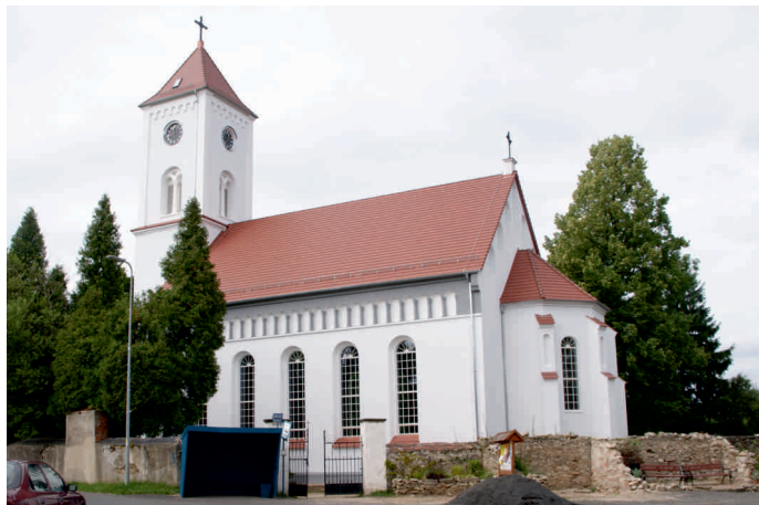
Tuż po zakończeniu prac remontowych
