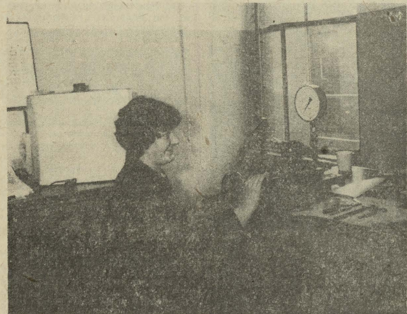
DANUTA RASIEWICZ - mechanik aparatury pomiarowo-regulacyjnej, pracuje na wydziale pomiarów i automatyki 10 lat. Jednym z jej obowiązków jest obsługa praski obciążnikowo-tokowej do sprawdzania ciśnieniomierzy.
