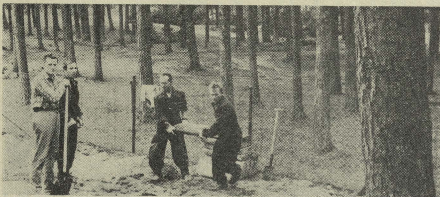
W roku 1965 członkowie naszych służb uczyli się i pracowali w ośrodku wypoczynkowym w Ustce, budując drogi dojazdowe i chodniki.
