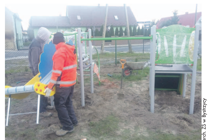
W minionym tygodniu na placu zabaw przy świetlicy zamontowano urządzenia na placu zabaw
