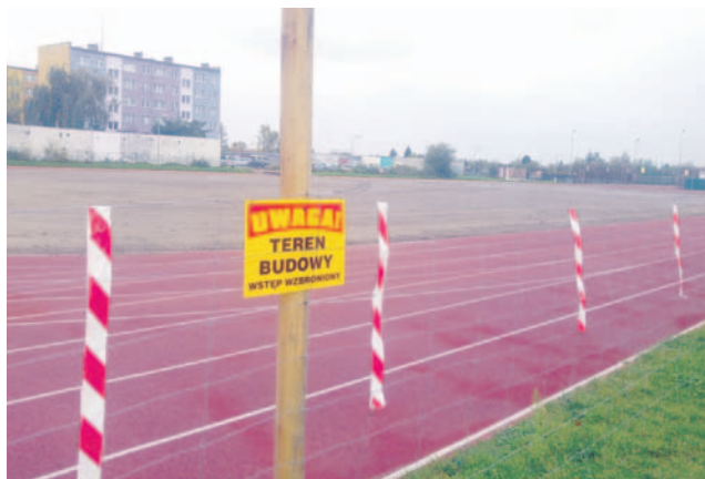
Gruntownie zmodernizowane boisko piłkarskie przy PSP nr 2 niebawem będzie gotowe...
