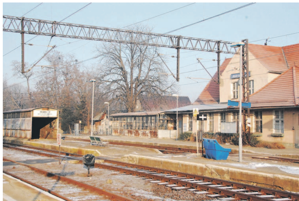
Dworzec w końcu doczeka się kompleksowego remontu
