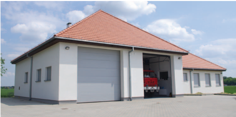
Strażacy już zagospodarowali nowy obiekt
