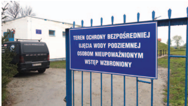
Stacja uzdatniania wody wymaga remontu
