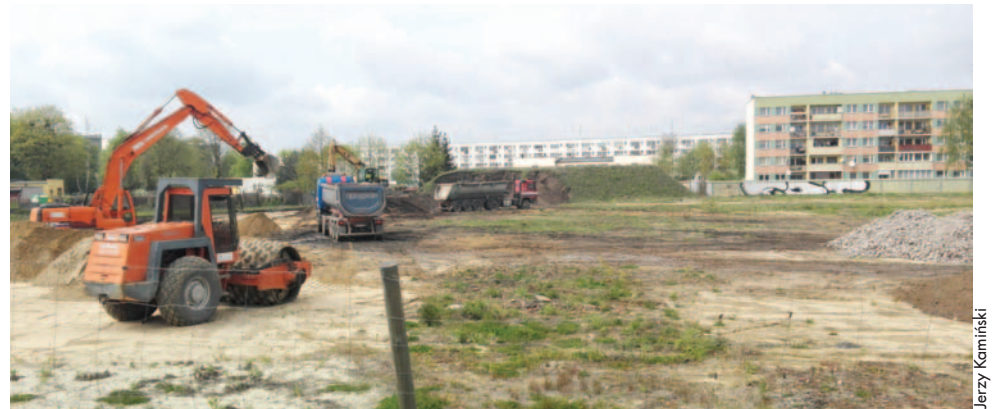
Teren jest przygotowywany pod budowę
