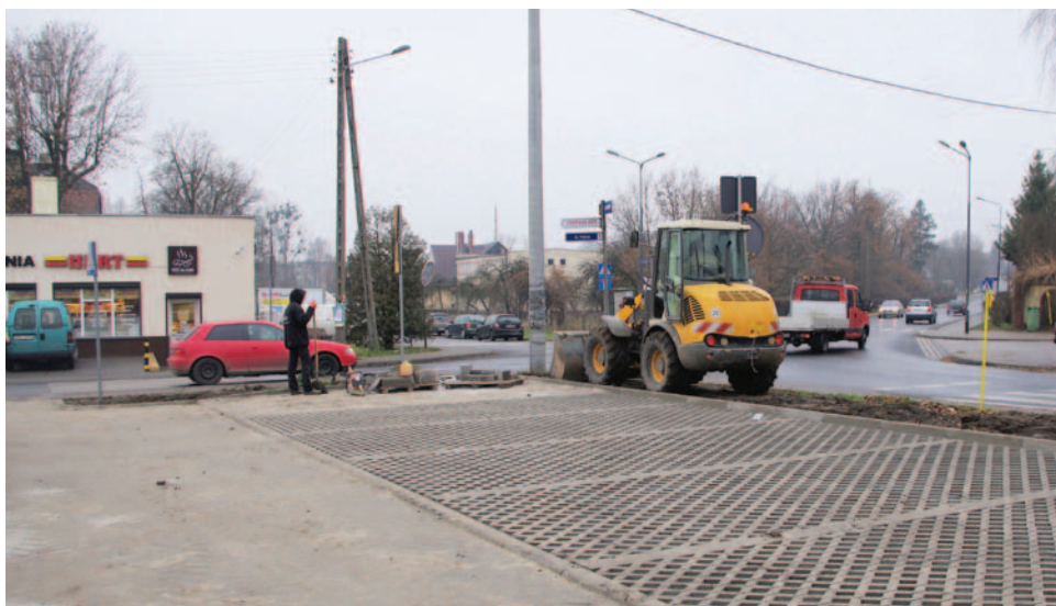
Prace nad nowymi miejscami parkingowymi dobiegają końca
