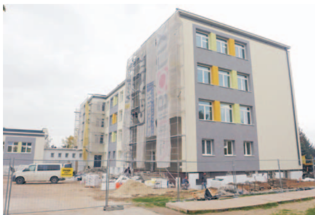
Dobiegają końca prace elewacyjne budynku Szkoły Podstawowej nr 2
