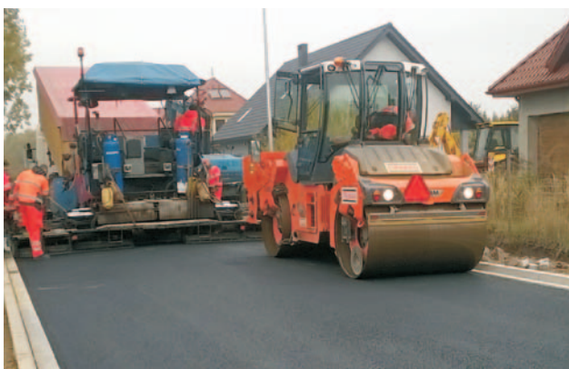
Na ulicy Kochanowskiego rozpoczęło się układanie asfaltu
