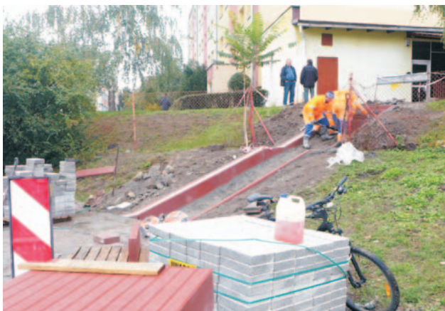
Zakończyło się wyburzenie starych schodów, prowadzących na targowisko miejskie. Już niedługo powstanie tam nowe, wygodniejsze zejście wraz z chodnikiem
