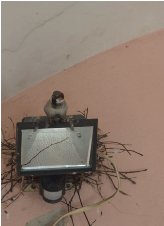
Zdjęcie zrobione kilka dni po zdarzeniu. Wróbel siedzi teraz przy gołębinym gnieździe i według Krystyny wciąż nawołuje pisklęta. Na tej samej ścianie jest założona nowa kratka wentylacyjna - tam miały przebywać małe wróble
