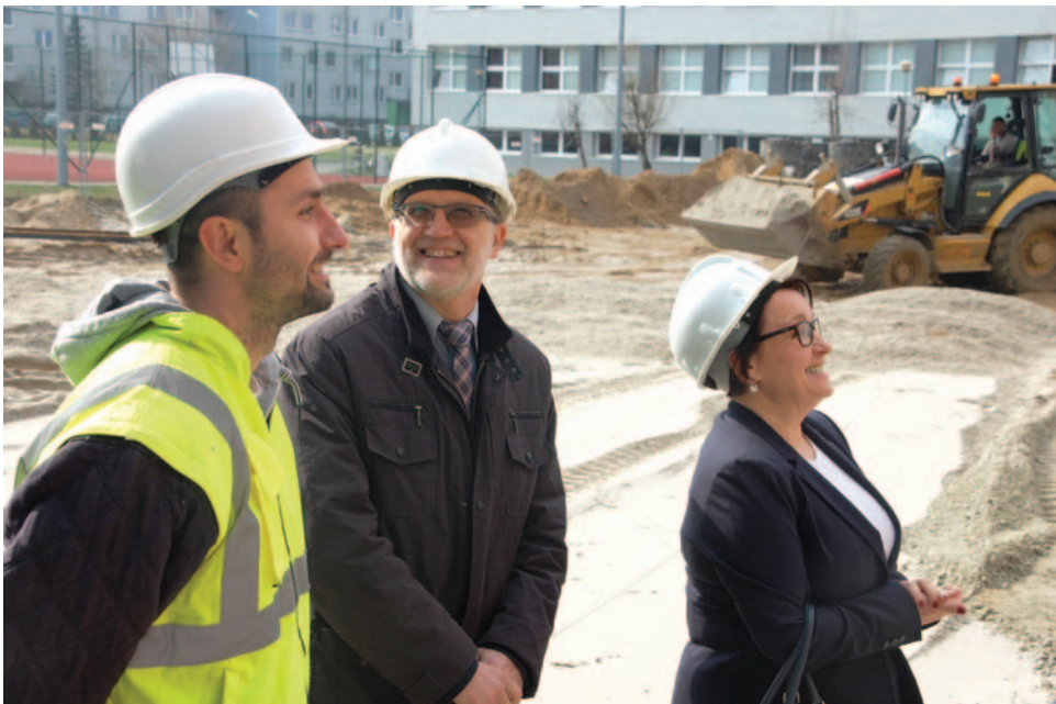
Na placu budowy
