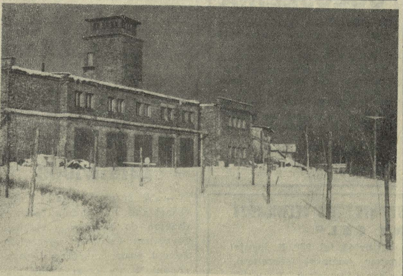
Siedziba naszej Straży Pożarnej widziana od strony portierni. Tutaj przez całą dobę czuwa się nad bezpieczeństwem przeciwpożarowym w Zakładzie. Fot. Z. Adamski
