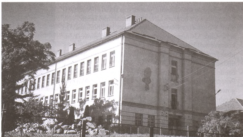
Szkoła w Osolinie. Dach po kapitalnym remoncie z wymienionymi rynnami.
