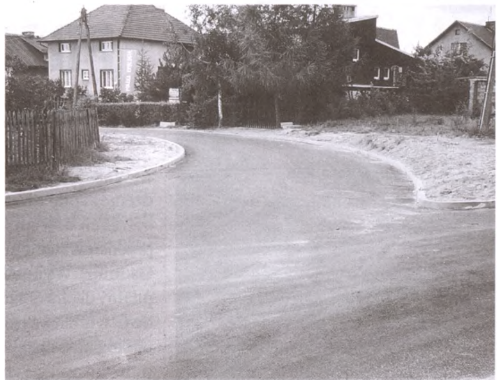
Nowa nawierzchnia asfaltowa ulicy Polnej.
