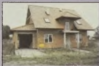
WROCŁAW-WIDAWA : dom wolno stojący, parterowy do wykończenia, pow. 140 m 2 , trzy kondygnacje (poddasze użytkowe), 5 pokoi, 2 łazienki, kuchnia, taras, garaż, szyby antywłamaniowe, działka 1015 m 2 , energia, gaz, woda, przewody inst. alarmowej, cena 250.000 zł
