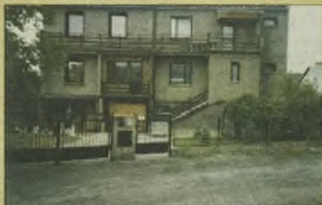
DOM , Wrocław - Krzyki, na firmę lub dla dwóch rodzin, 6 pokoi, 2 kuchnie, 2 łazienki, kotłownia, pomieszczenie techniczne, pralnia, suszarnia, garaż, atrakcyjna cena, - 400.000 zł
