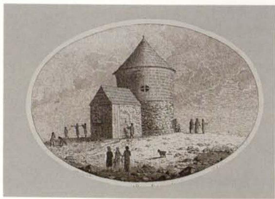
4. Friedrich G. Endler, Kaplica na Śnieżce , akwaforta, pocz. XIX w. Kaple na Sněžce , lept, zač. 19. stol. Kapelle auf der Schneekoppe , Kupferstich, Anfang d. 19. Jh.
