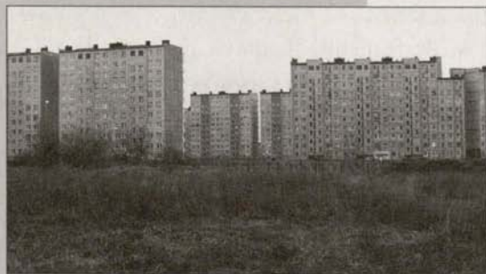
Betonowa ściana Zabobrza
