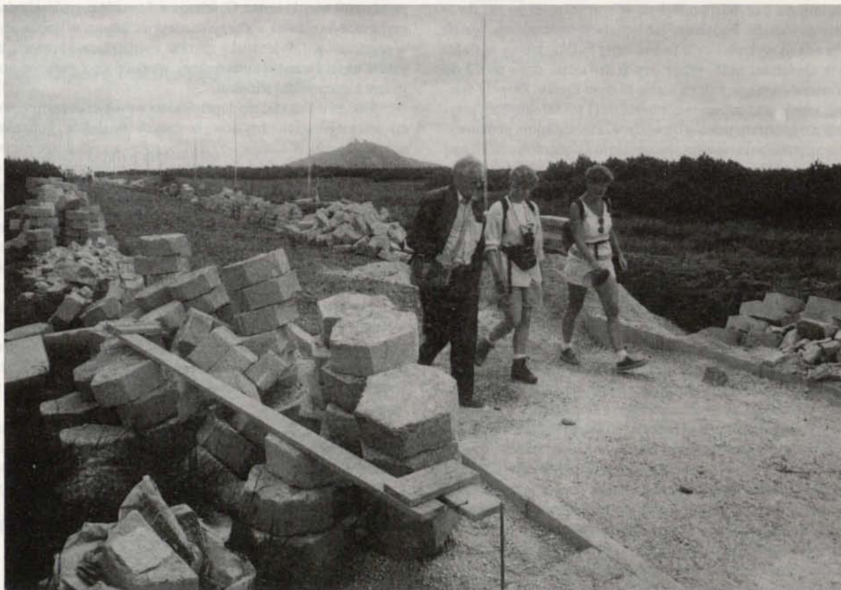
Podobną betonową tryliną KPN wyłożył drogę od Wodospadu Kamieńczyk do Hali Szrenickiej
