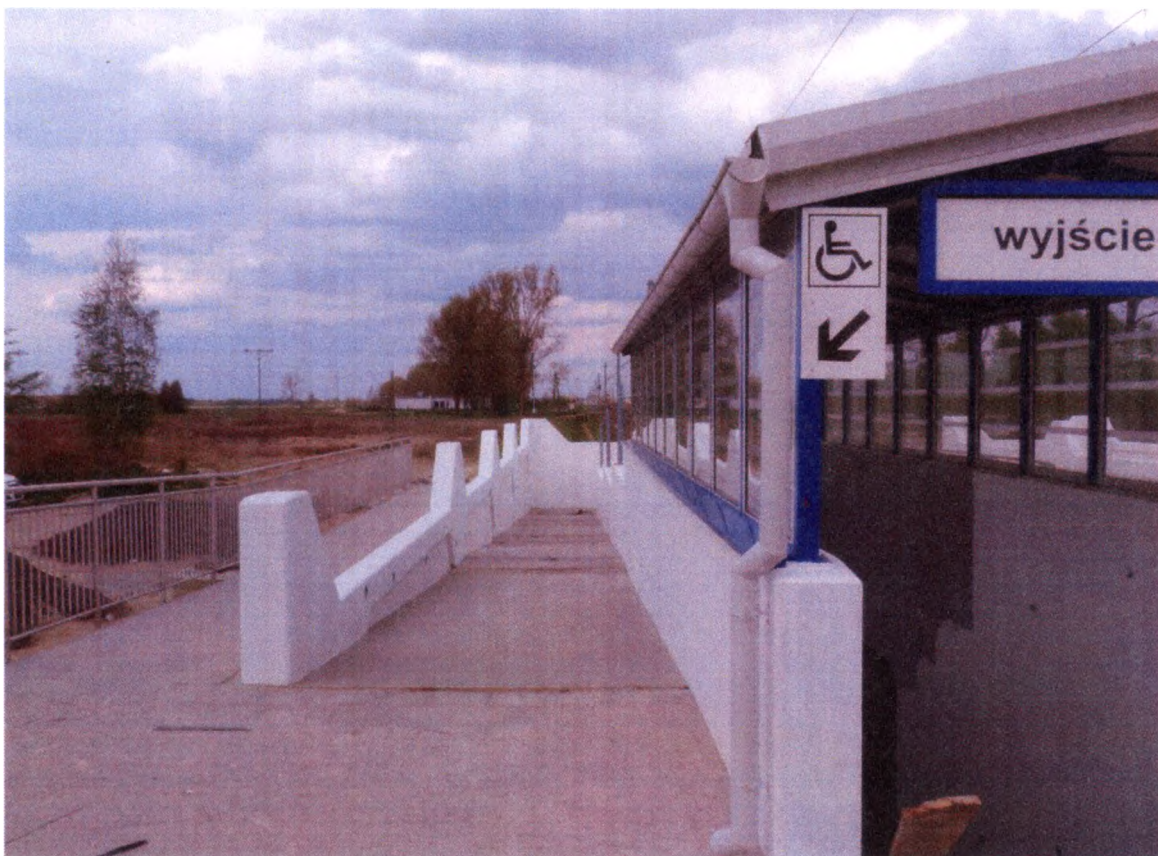
Ryc. nr 21. Pochylnia przy przejściu pod torami w Garbcach – fot. własna
