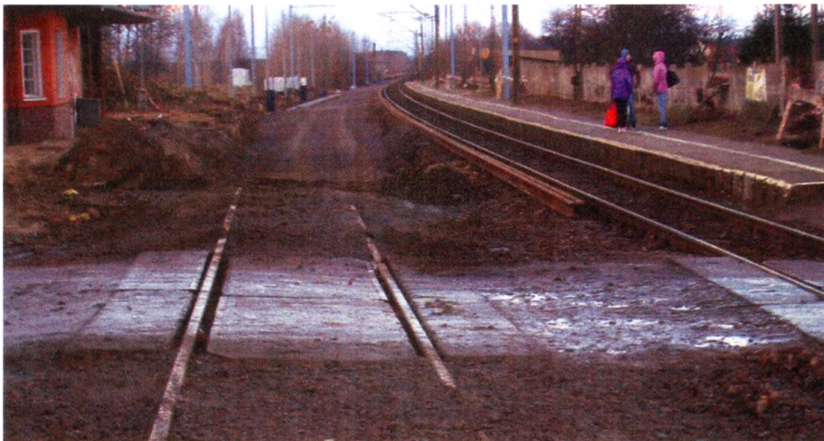
Ryc. nr 27. Zanieczyszczona droga w rejonie przejazdu w Osoli – fot. własna
