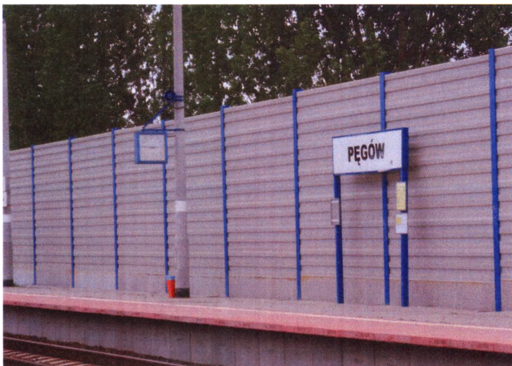
Ryc. nr 20. Ekran dźwiękochłonny na stacji Pęgów – fot. własna
