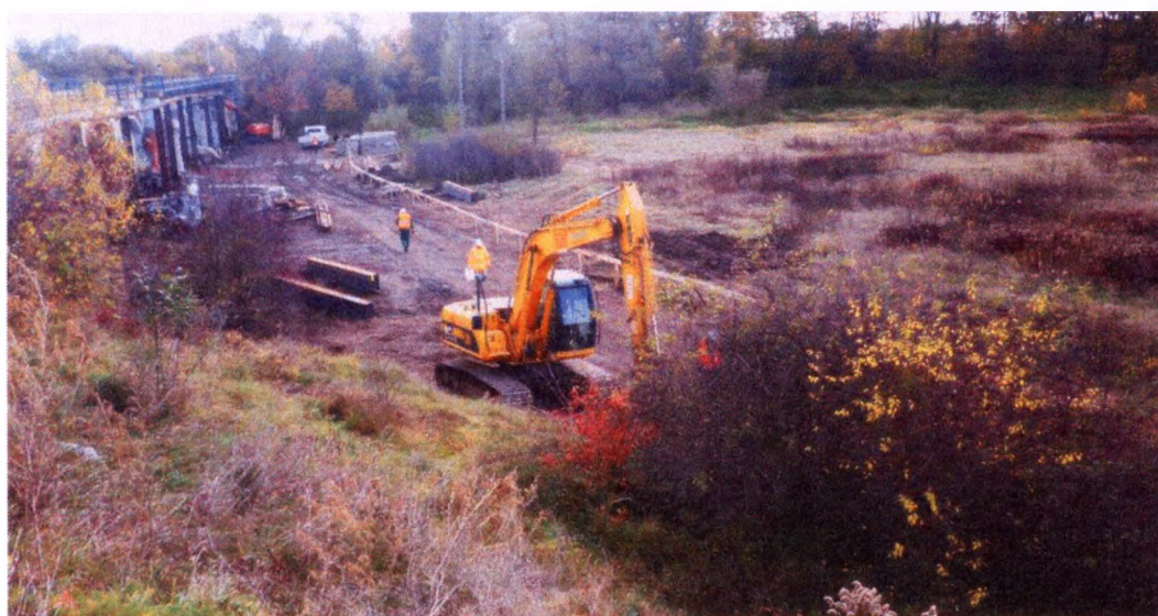
Ryc. nr 24, 25. Wygradzenie placu budowy w obszarze chronionym Dolina Widawy – fot. wł.
