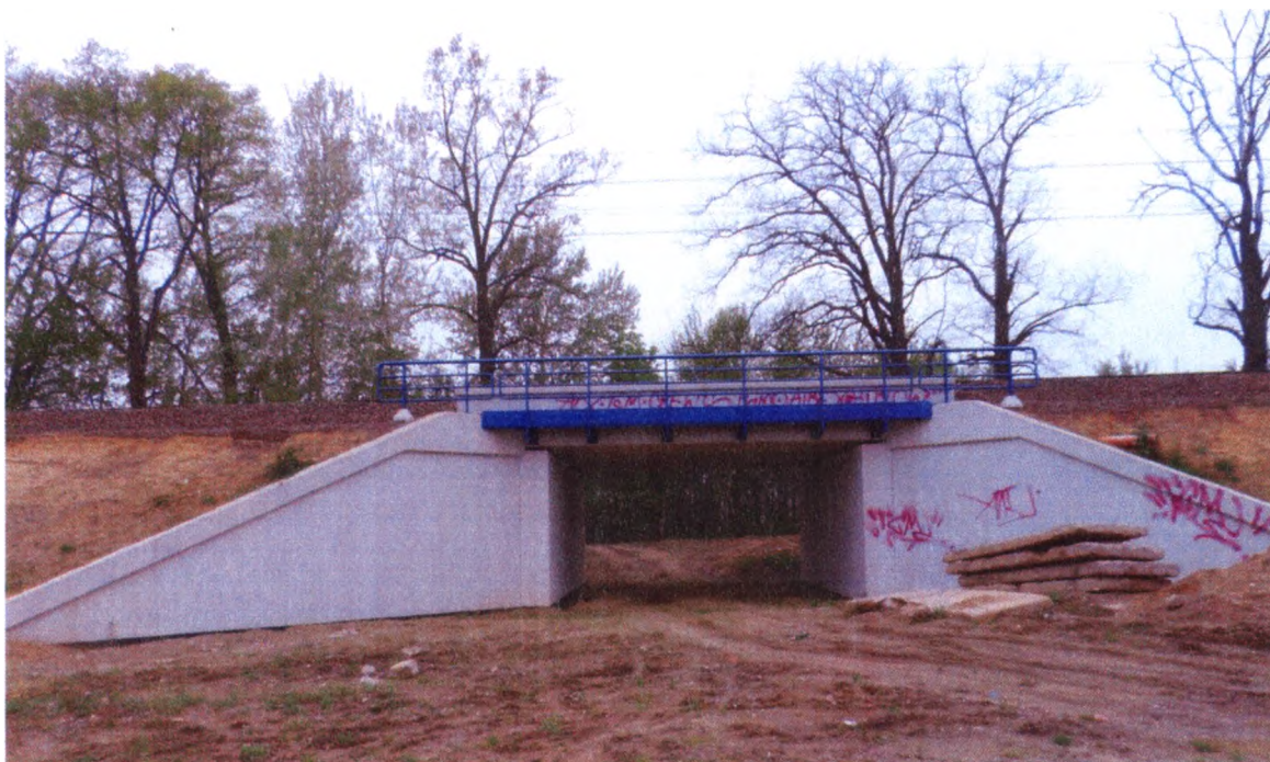
Ryc. nr 17. Przejście dla dużych zwierząt pod torami km 24,800 (Oborniki Śl.) – fot. własna
