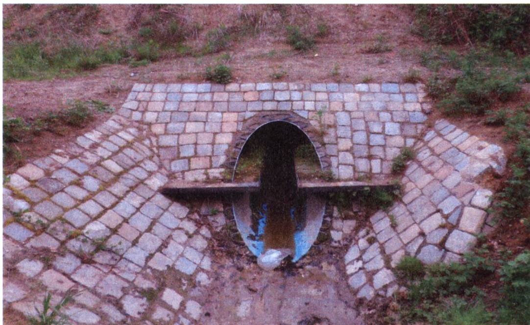
Ryc. nr 14. Półki wewnątrz przepustu dla migracji małych zwierząt – fot. własna
