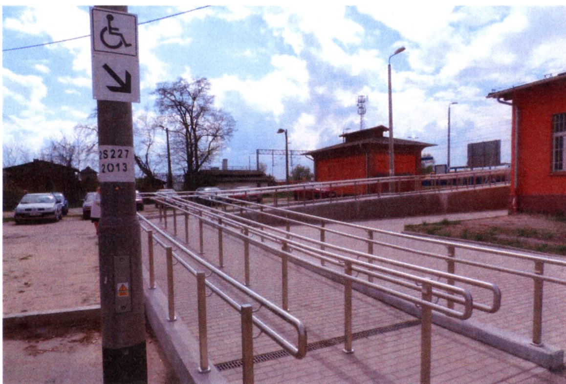
Ryc. nr 22. Pochylnia dla osób niepełnosprawnych w Żmigrodzie – fot. własna
