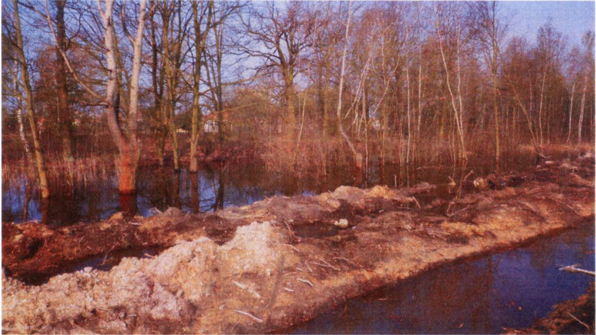
Ryc. nr 26. Zaburzenie gospodarki wodnej przy robotach ziemnych w Garbcach – fot. wł.
