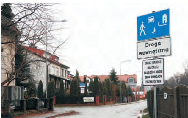
Na ul. Makowej i innych na Osiedlu Domków Jednorodzinnych obowiązuje strefa zamieszkania i można parkować tylko w miejscach do tego przeznaczonych
