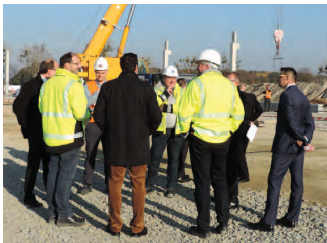
Na terenie przyszłej fabryki w Godzikowicach
