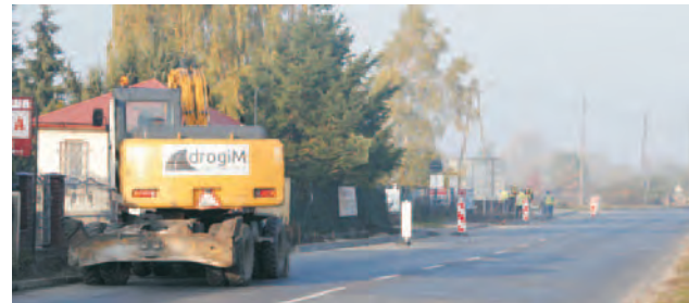
Budowa chodnika przy fragmencie drogi wojewódzkiej 455 w J-L i w Łęgu ma być rozliczona do końca roku
