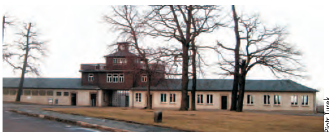
Brama główna obozu koncentracyjnego w Buchenwaldzie, gdzie po nocy kryształowej przewieziono Żydów z Ohlau oraz Kurta, ojca Ilse
