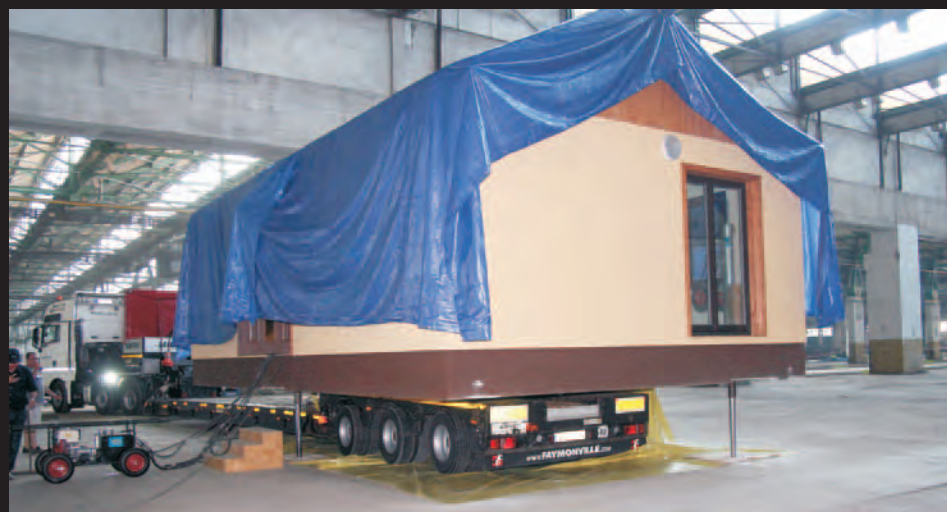
Specjalna technologia pozwala na podniesienie tego domu bez dźwigu, za pomocą trzech siłowników
