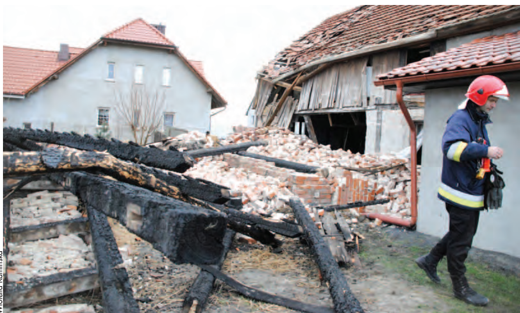
Fragment spalonej stodoły przewrócił się i uszkodził sąsiedni budynek
