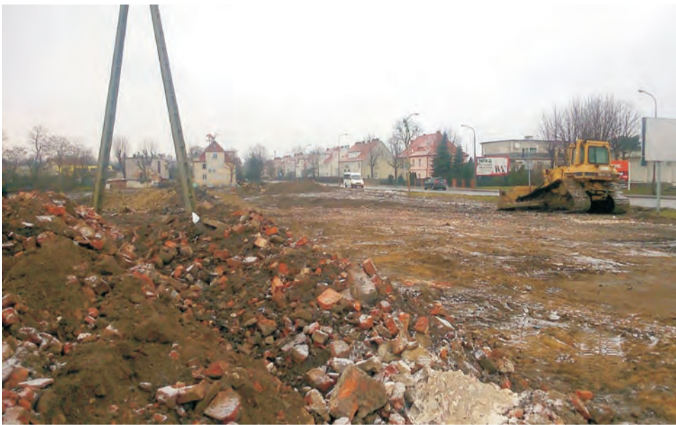
Przy ulicy Opolskiej wycięto już drzewa i wyrównano teren
