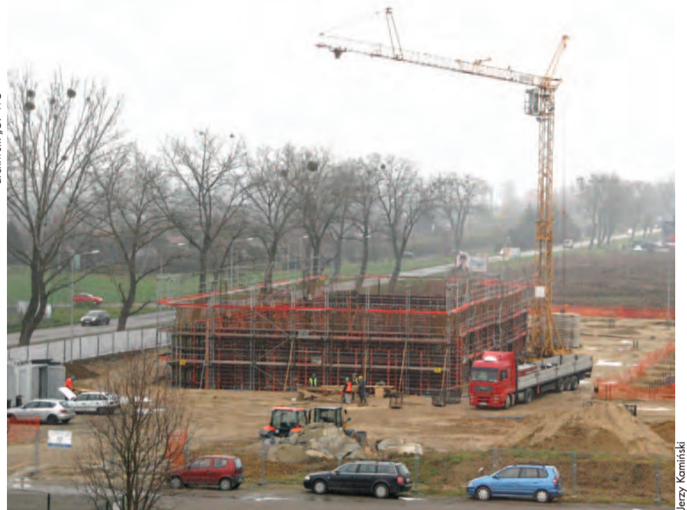
Jeszcze w październiku trwały tu prace. Teraz te szalunki rozebrano
