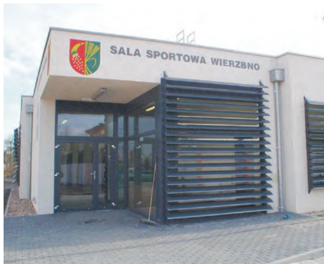
Przed oddaniem do użytku obiekt czeka jeszcze kilka poprawek
