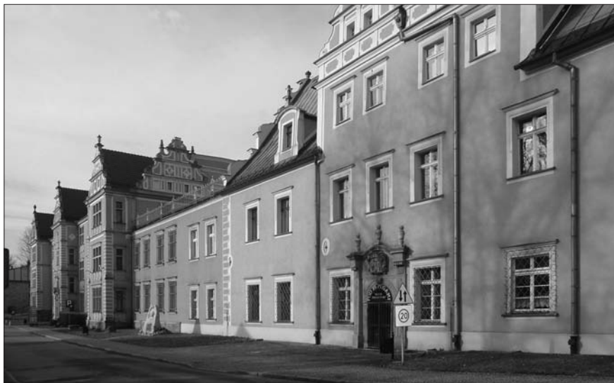
Ryc. 5. Pałac, ul. Zamkowa 4 – widok od strony dziedzińca
