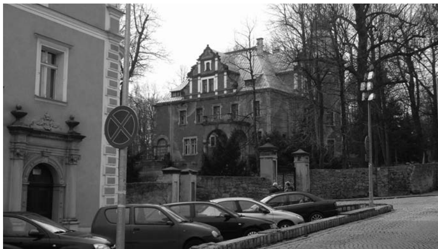
Ryc. 13. Dawna willa Hochbergów, ul. Zamkowa 2 – widok od strony ul. Zamkowej
