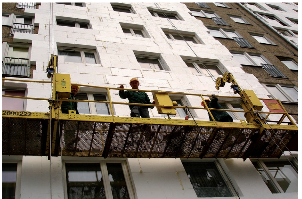
Roboty dociepleniowe budynku przy ulicy Zygmunta Noskowskiego 9. Fot. Grażyna Tęcza
