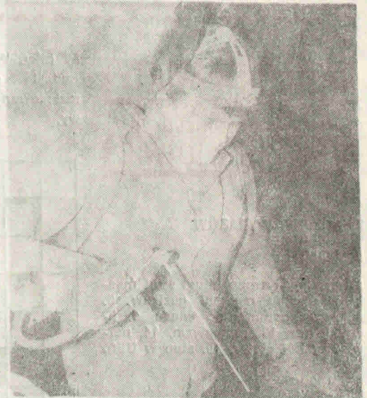
Jerzy Miksza — spawacz w brygadzie R. Szuklarka na stanowisku pracy. Na zlecenie WDI Świdnica Przedsiębiorstwo Modernizacji i Remontów wykonywało urządzenia niezbędne dla realizacji zadania: „woda dla Białbrzycha”.
