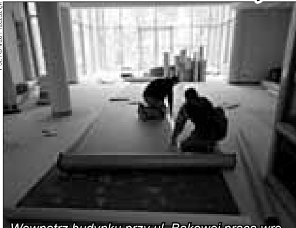
Wewnątrz budynku przy ul. Bakowej praca w re
