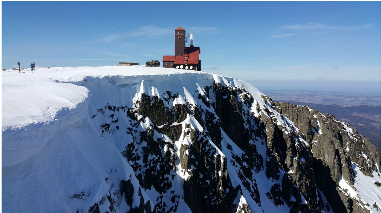
Stacja przekaźnikowa na Śnieżnych Kotłach. Foto: Krzysztof Tęcza
